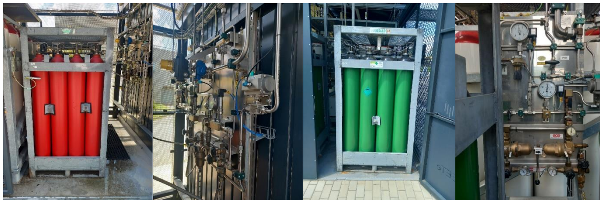
OBRÁZEK 3: SVAZKY TLAKOVÝCH LAHVÍ, PŘIPOJOVACÍ PANELE
