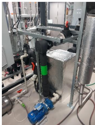
OBRÁZEK 7: OKRUH CHLAZENÍ PALIVOVÉHO ČLÁNKU
