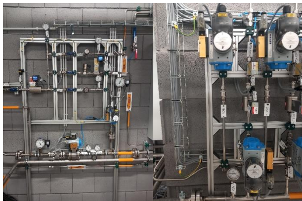
OBRÁZEK 5: VSTUPNÍ PLYNOVÝ PANEL A PLYNOVÝ PANEL PALIVOVÝCH ČLÁNKŮ
