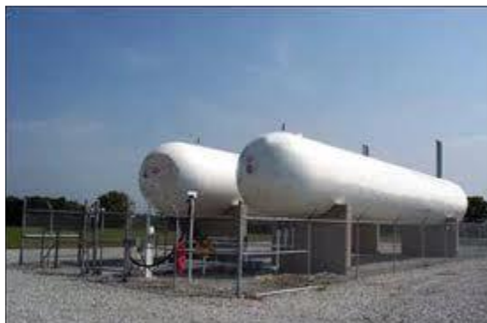
OBRÁZEK 8.1: VIZUÁLNÍ PŘÍKLAD SKLADOVÁNÍ AMONIAKU V TLAKOVÉ NÁDRŽI [16].
