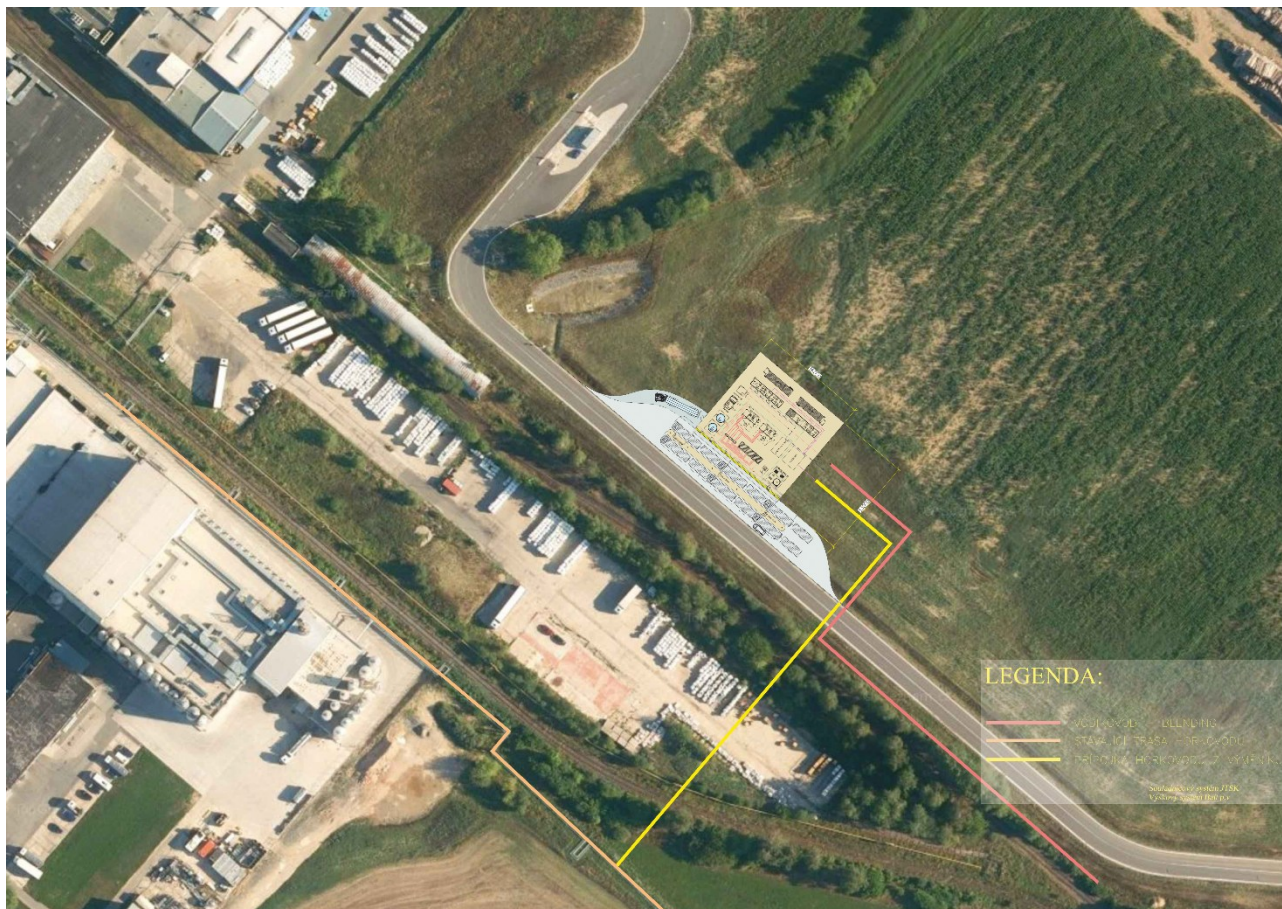
OBRÁZEK 8 – VÝROBNA VODÍKU A VODÍKOVÁ ČERPAČÍ STANICE
